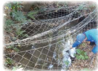
No. 3 大井中ノ橋前145-1
