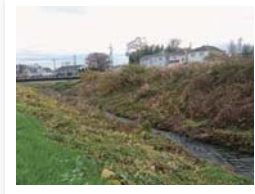
No.10 導水注入後
