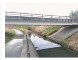
No.9 導水注入前
