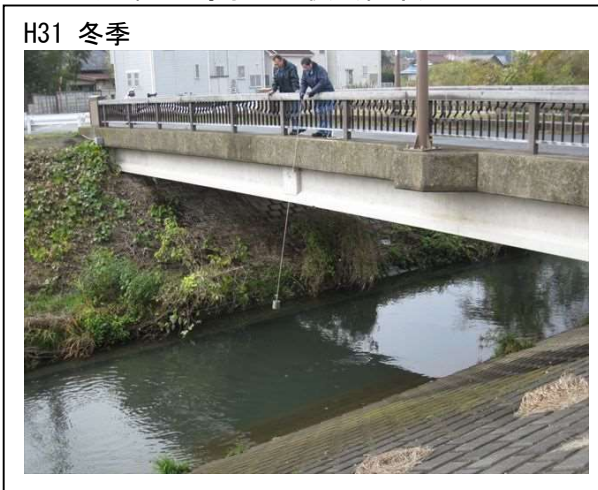
No. 10 大堀川 導水注入後（柏市）
