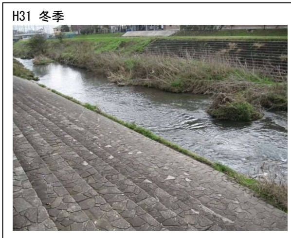
No. 14 大堀川 高田緑地前（柏市）
