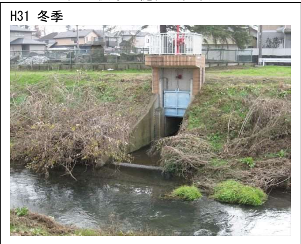
No. 11 大堀川 後原上樋管（柏市）
