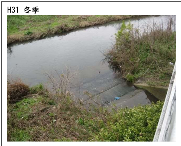
No. 13 大堀川 西前田樋管（柏市）
