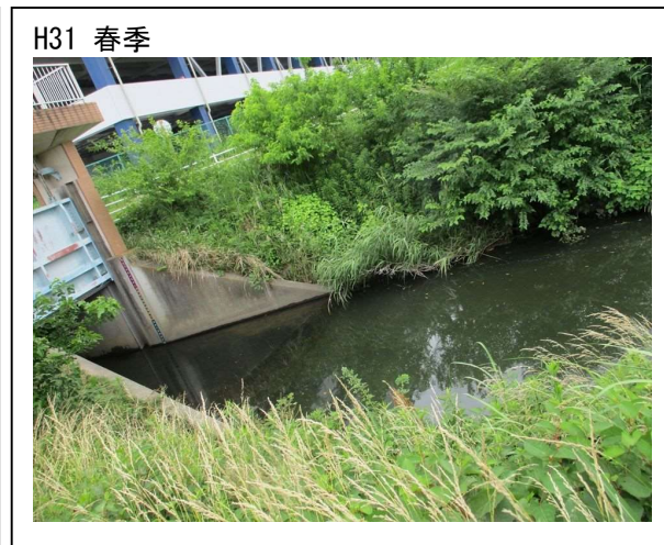
No. 19 大堀川 地金堀樋管（柏市）
