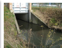
No.19 地金堀樋管
