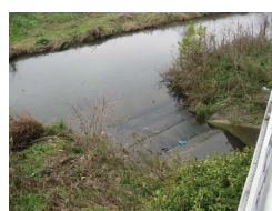
No.13 西前田樋管
