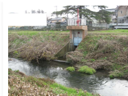
No.11 後原上樋管
