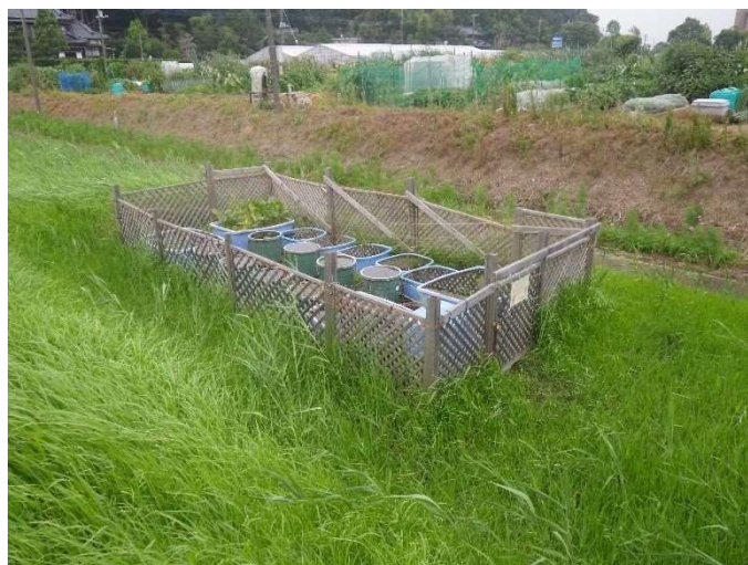
図 2-8 木製フェンス設置状況
