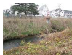
No.11 後原上樋管
