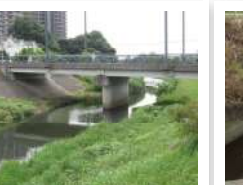
No.18 地金堀合流前
