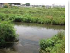
No.13 西前田樋管
