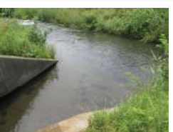
No.12 天神前樋管
