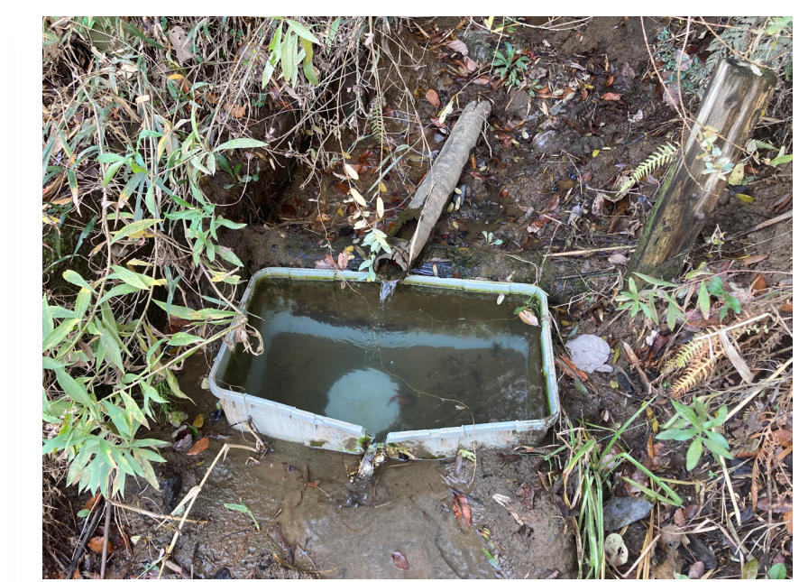
No.17 古新田川防災調整池
